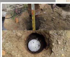
⑥施工完了
