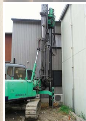
▲回転貫入工法であるため低振動、低騒音施工。排土も発生しません。
