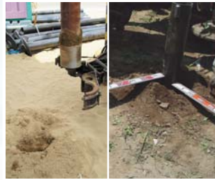
⑤ 回転貫入完了 ⑥ 施工完了 (杭頭スレ確認)
