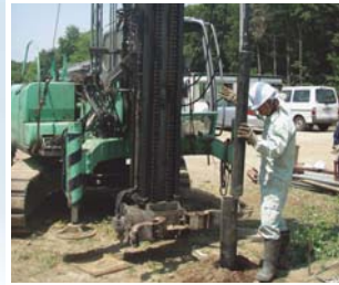
⊕α(1) 杭先端部モンケン落下
