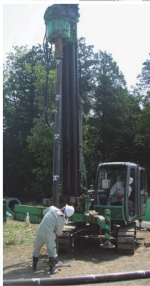
① 杭の建て込み
