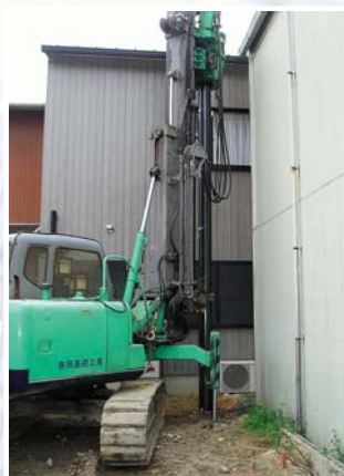
▲回転貫入工法であるため低振動、低騒音施工。排土も発生しません。
