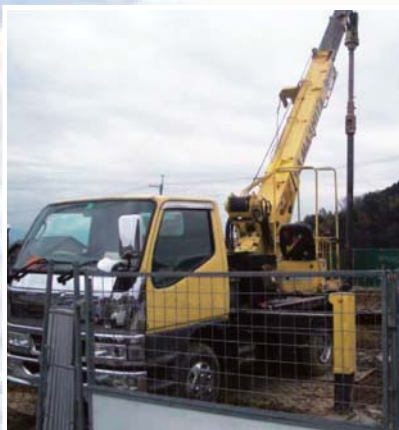
建柱車での施工
